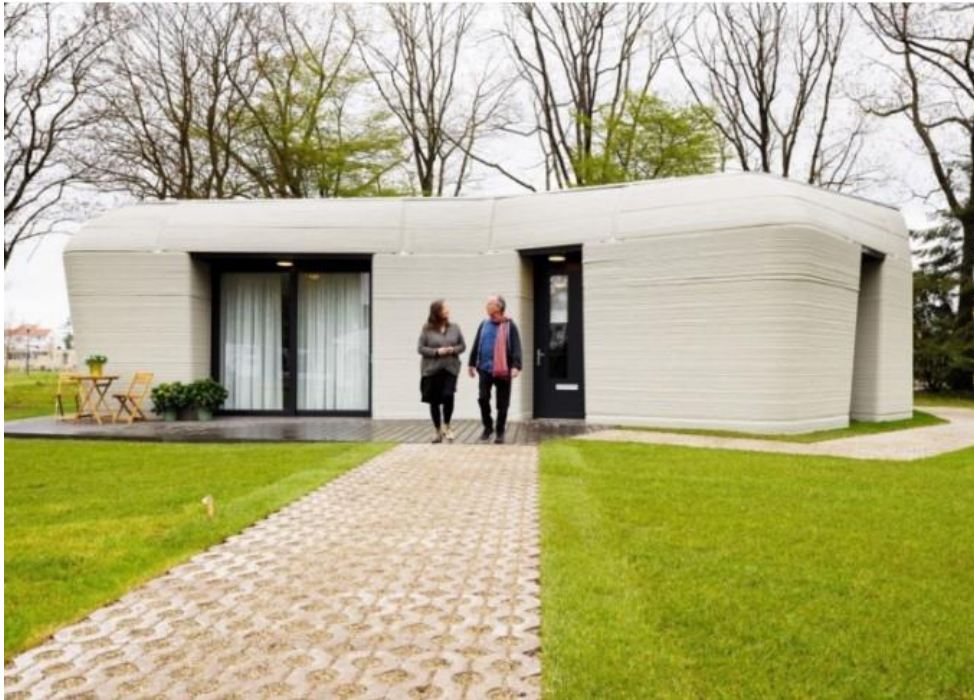
2 pav. 3D technologija spausdintas gyvenamasis namas. Projektas „Milestone“, architektai Houben ir Van Mierlo, aut. Bart van Overbeeke
