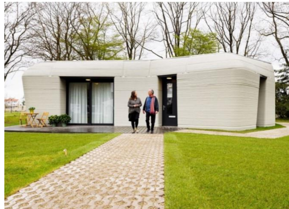
2 pav. 3D technologija spausdintas gyvenamasis namas. Projektas „Milestone“, architektai Houben ir Van Mierlo, aut. Bart van Overbeeke
